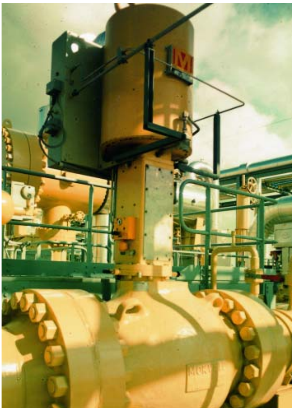
Клапан HIPPS 16" ANSI 1500 на компрессорной станции, Германия.
